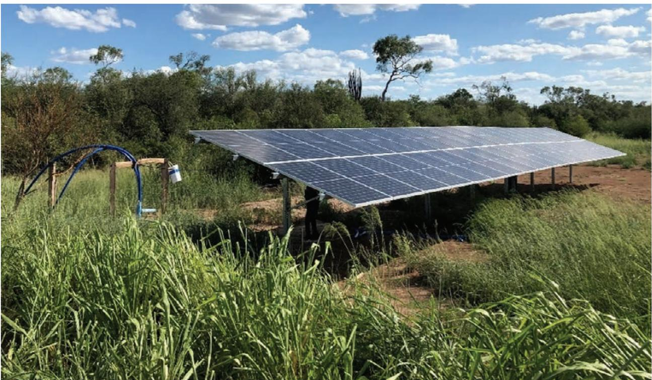
**Figura 6.** Planta solar con bomba sumergible.
