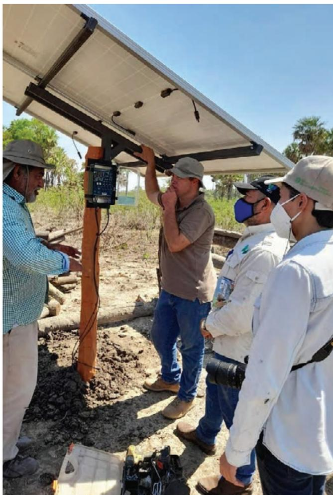
Figura 3. Instalación de paneles solares para sistema de provisión de agua.
